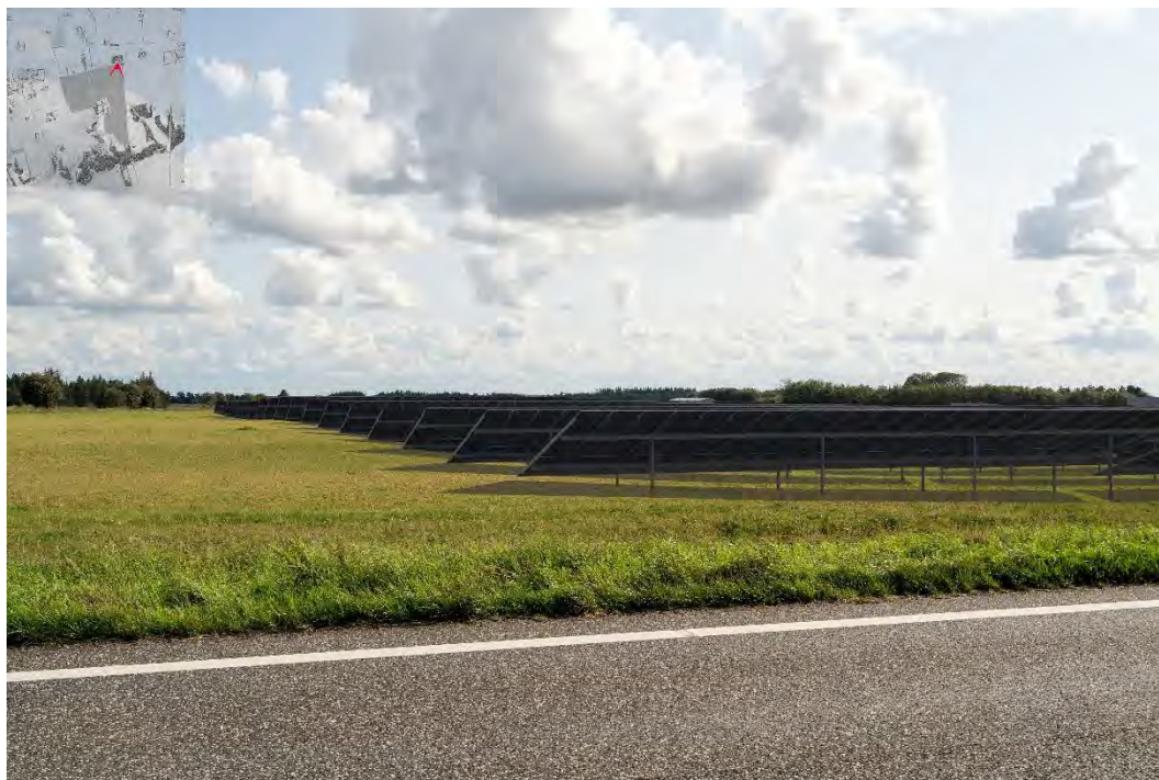
Figur 7-18. Fotostandpunkt 3 – Landskabet umiddelbart efter opstilling af solpaneler.
