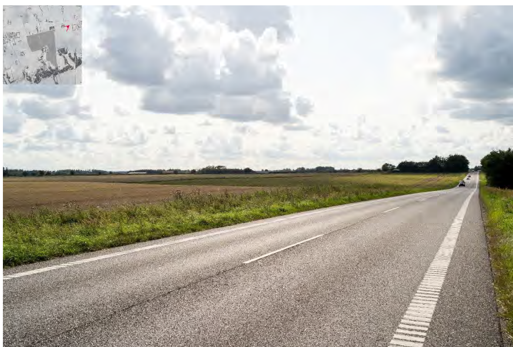
Figur 7-21. Fotostandpunkt 4 – Landskabet umiddelbart efter opstilling af solpaneler.
