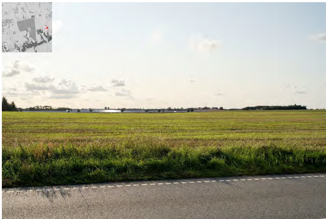
Figur 7-24. Fotostandpunkt 5 – Landskabet umiddelbart efter opstilling af solpaneler.
